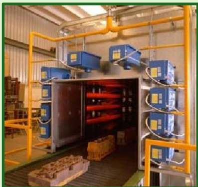
Модуль регулятора мощности M25 в промышленной сушильной печи
